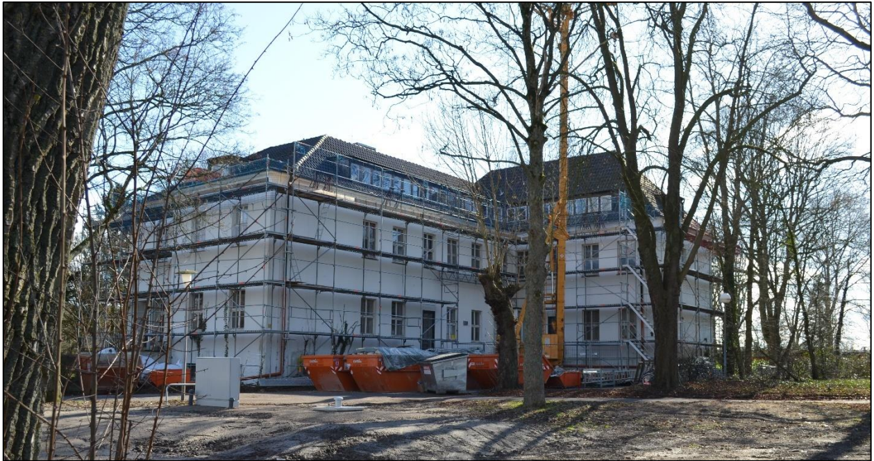
Foto 2: Solitäre Bebauung auf dem nördlichen Teilbereich der Außenbereichssatzung
